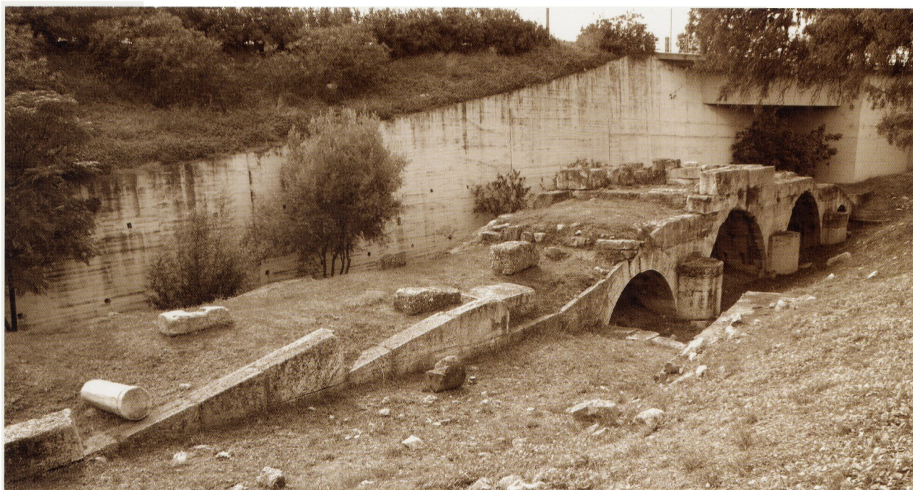
Άποψη της γέφυρας από βορειοανατολικά (2010)
