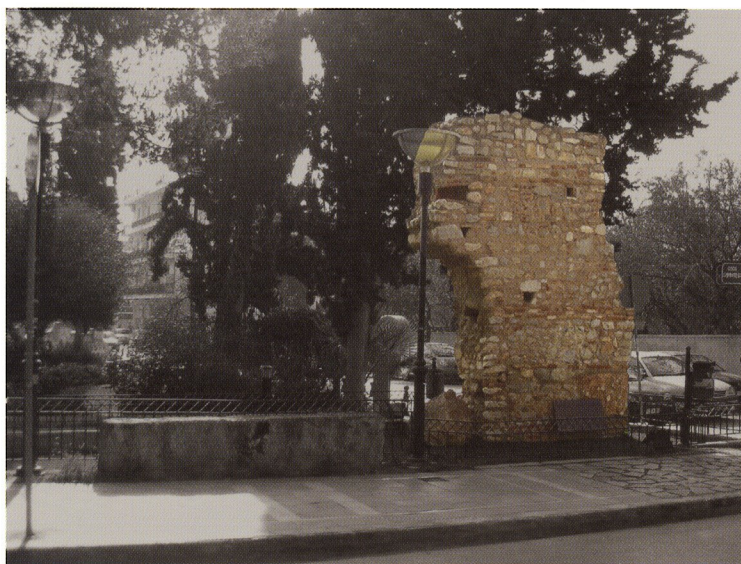
Απόψεις σωζόμενων τμημάτων του υδραγωγείου στην οδό Δημήτρος
