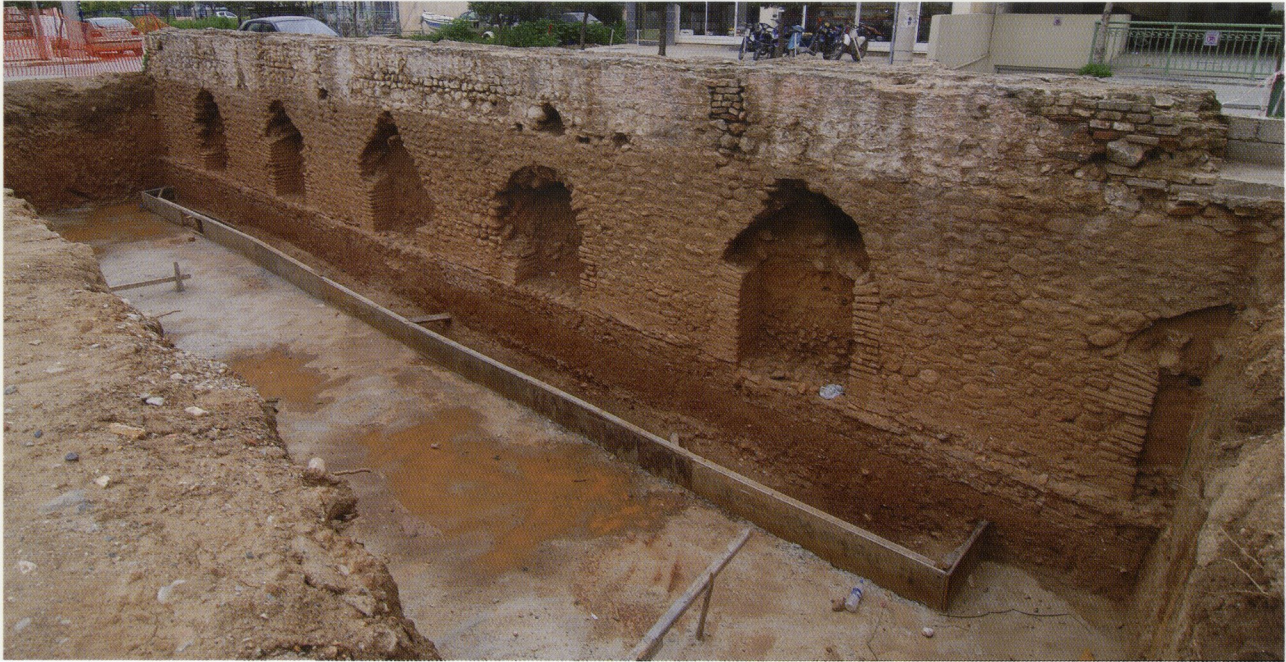
Άποψη τμήματος του ρωμαϊκού υδραγωγείου στην οδό Δήμητρος (2011)
