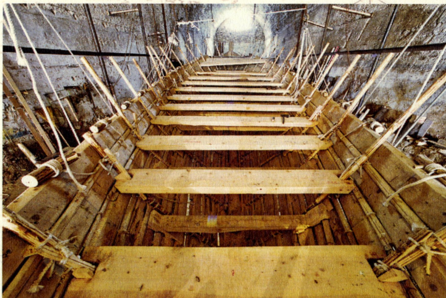
Εσωτερικό του πλοίου, τοποθέτηση "σελμάτων" και "υποποδιών" για να πατάνε οι κωπηλάτες
