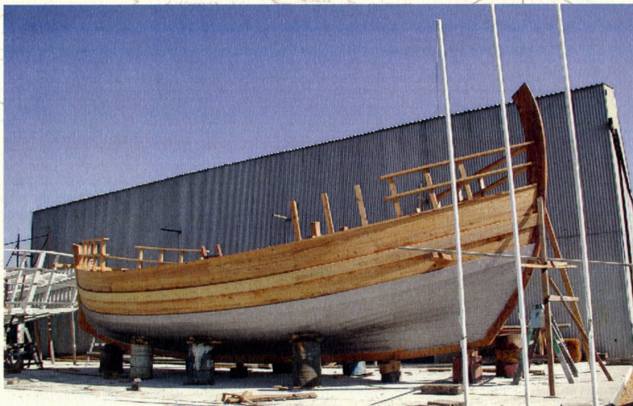
Κατασκευή του Κερύνεια Ελευθερία 21/9/2004
