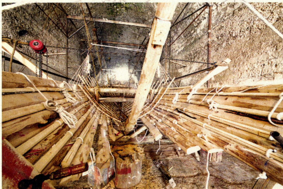
Ανέλκυση σχεδίας με παλάγγα, διαμόρφωση ατράκτου (δεν υπήρχαν τότε οι νομείς) σε ημικυλινδρικό σώμα
