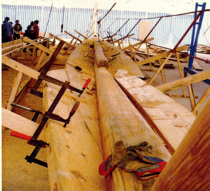
Φωτογραφία από τα πρώτα στάδια κατασκευής
